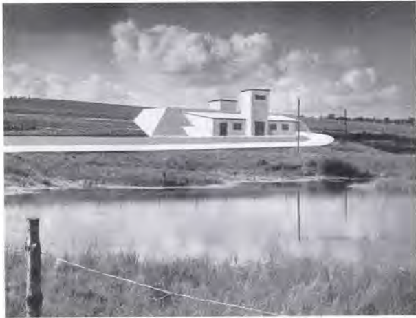
Fig. 87. Model af Drastrup vandværk, som blev taget i brug i 1958. Det kan levere 300 m 3 pr. time. Aalborg vandforsyning.
