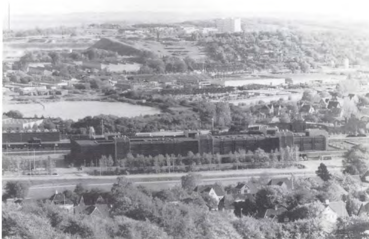
Fig. 60. Cementfabrikken Danmark's gamle lergrav i Østerådalen, sydøst for Kjærs Mølle. Aalborg Kommune.
